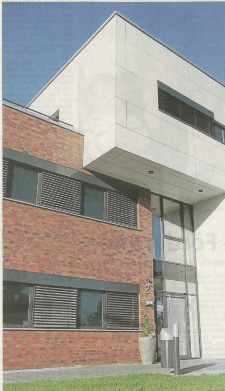
In dem über 1100 Quadratmeter großen Gründer- und Innovationspark Steinfurt GRIPS III befinden sich Räume mit modernster Ausstattung. Aber auch von außen macht das vor einer Woche eröffnete Gebäude am Steinfurter Campus was her.
