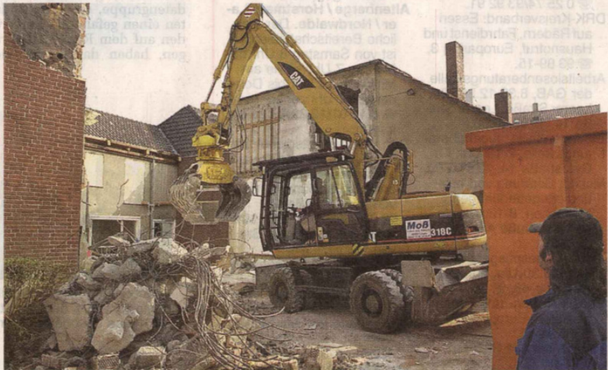
Der Abrissbagger ist bereits dabei, die alte Werkstatt abzutragen. Dort sollen kleine Gartenparzellen für die zukünftigen Bewohner entstehen. Foto: Drunkenmöle
