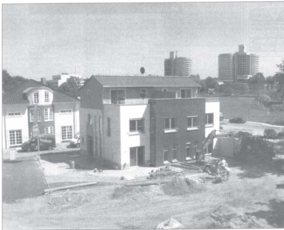
Die letzten Arbeiten am SUCCESS Haus Heiner Brand im urbaneum : Münster laufen. Am heutigen Samstag wird das exklusive Beispielhaus eröffnet.
