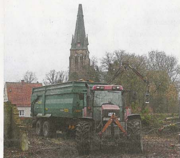
Die letzten Rodungsarbeiten laufen derzeit. Im März soll ausgeschachtet werden.
