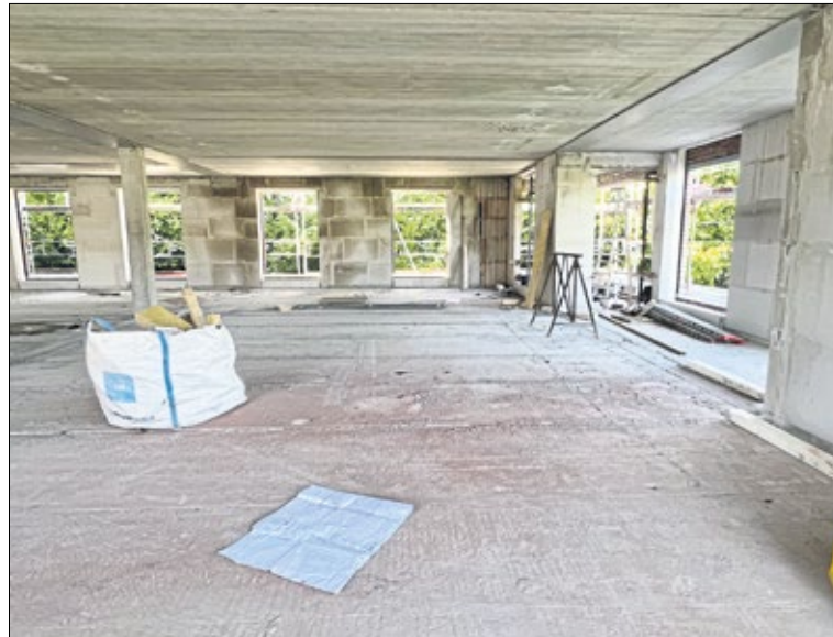
Rohbau des Großraumbüros für die Redaktion, Mai 2023.
