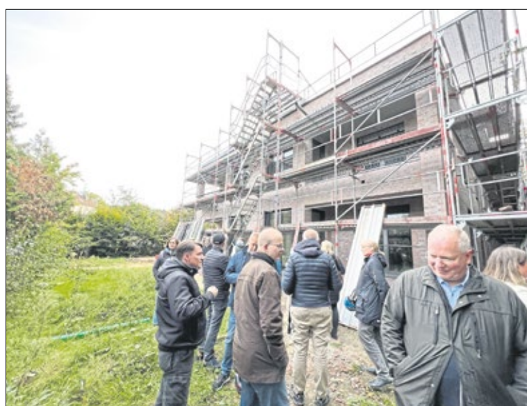
Alle Mitarbeitenden besuchen die Baustelle, Oktober 2023
