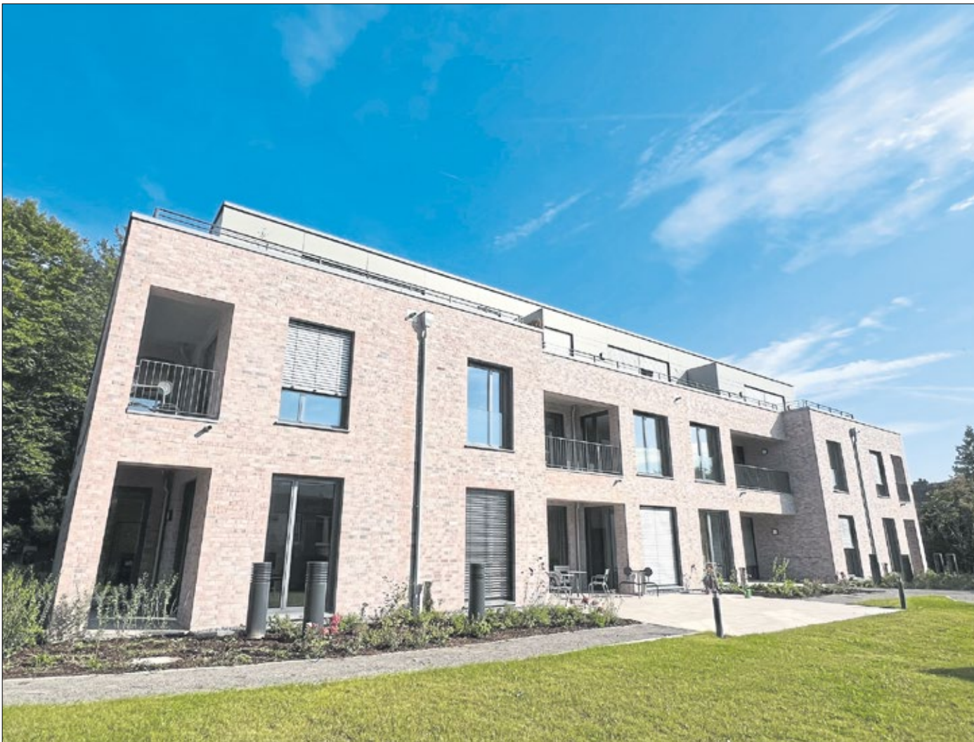
Das neue Dialog Medien Haus mit zwei Büroetagen und einem Wohnungsgeschoss. Nach anderthalb Jahren Bauzeit ist es hinter dem bisherigen Sitz, der ehemaligen Bonifatiuskirche, fertig geworden.
