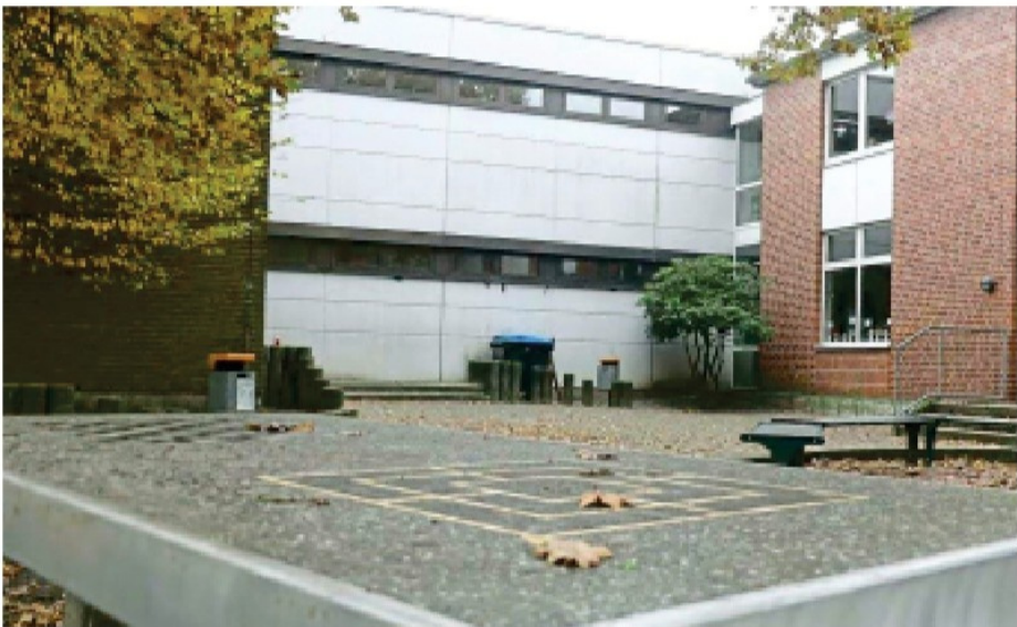
Der eingeschossige Anbau entsteht im Randbereich des hinteren Schulhofes der St.-Georg-Grundschule, zwischen Klassentrakt und Treppenhaus.
